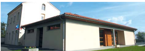
La nouvelle salle polyvalente, attenante à la mairie.
