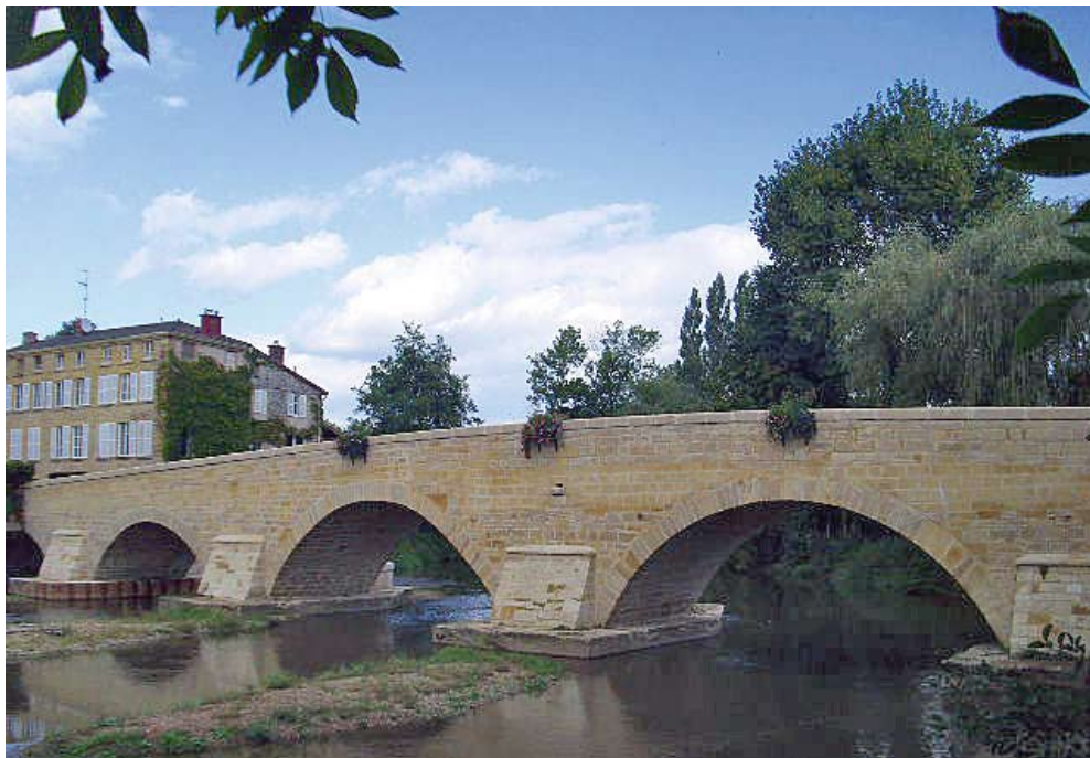
► Ce pont du 12 e siècle, qui enjambe le Sornin, a retrouvé une seconde jeunesse.
