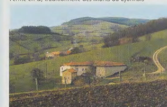
Ferme en U, traditionnelle des Monts du Lyonnais
