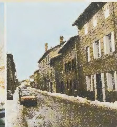
Marlhes, architecture en pierres appareillées, grises
