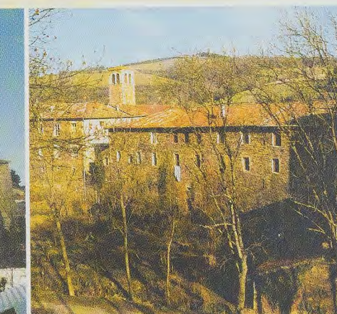
La Chartreuse de Sainte-Croix-en-Jarez. Un élément important du patrimoine architectural et historique du département de la Loire
