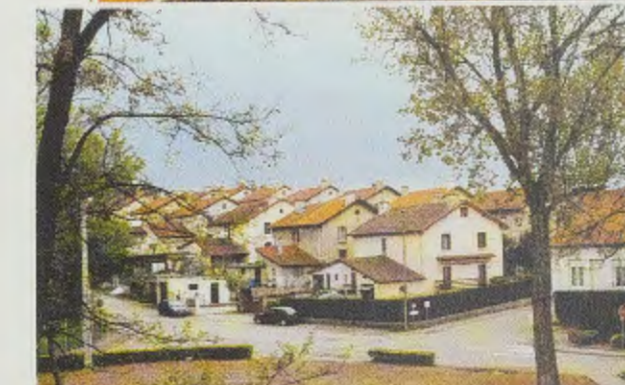
Habitat ouvrier à Roche-la-Molière
