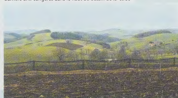
Barrière anti-congères dans le haut du bassin de la Coise
