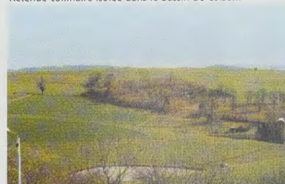
Retenue collinaire isolée dans le Bassin de Coise...
