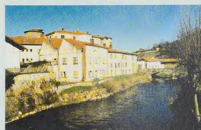
Usine (exceptionnellement enduite) au fil de l'eau, à Régny, au bord du Rhins
