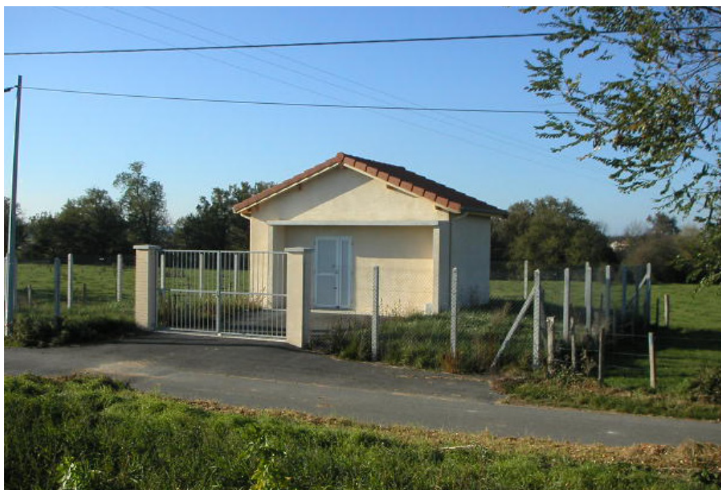
DDT 42 - Station de pompage interconnexion SI Lignon - SI Bombarde.
