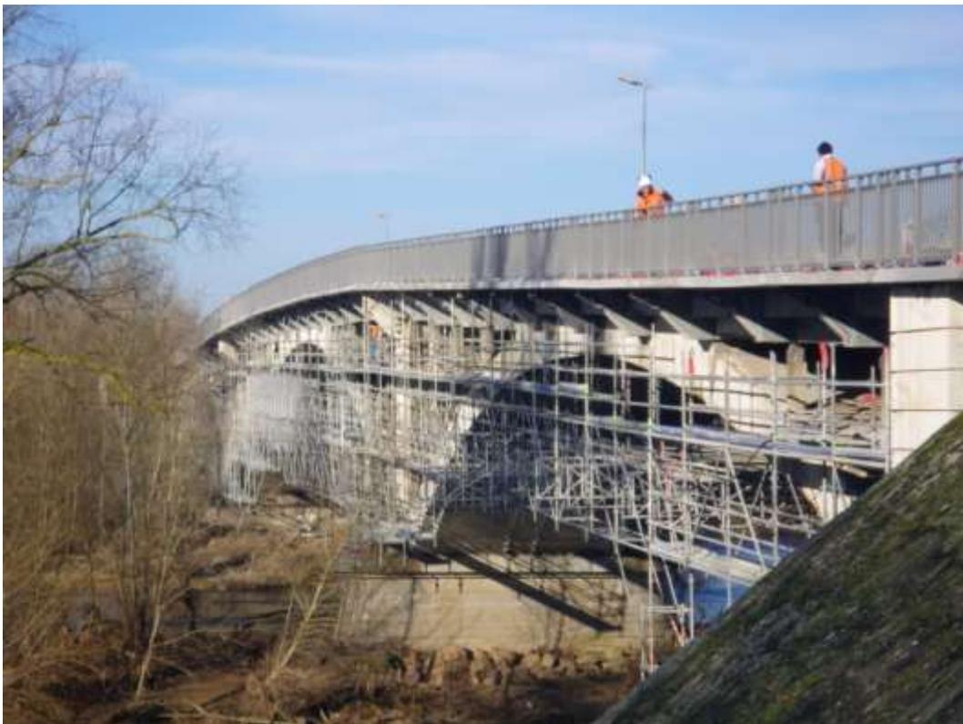
Le pont situé entre Pouilly sous Charlieu et Briennon permet à la route départementale n°4 de franchir la Loire. D'une longueur de 180 mètres, il est constitué de trois arcs en béton armé. Il est prolongé de part et d'autre par des rampes d'accès de plus de 100 mètres chacune. Ce sont donc 400 mètres d'ouvrage qui sont concernés par les travaux.
