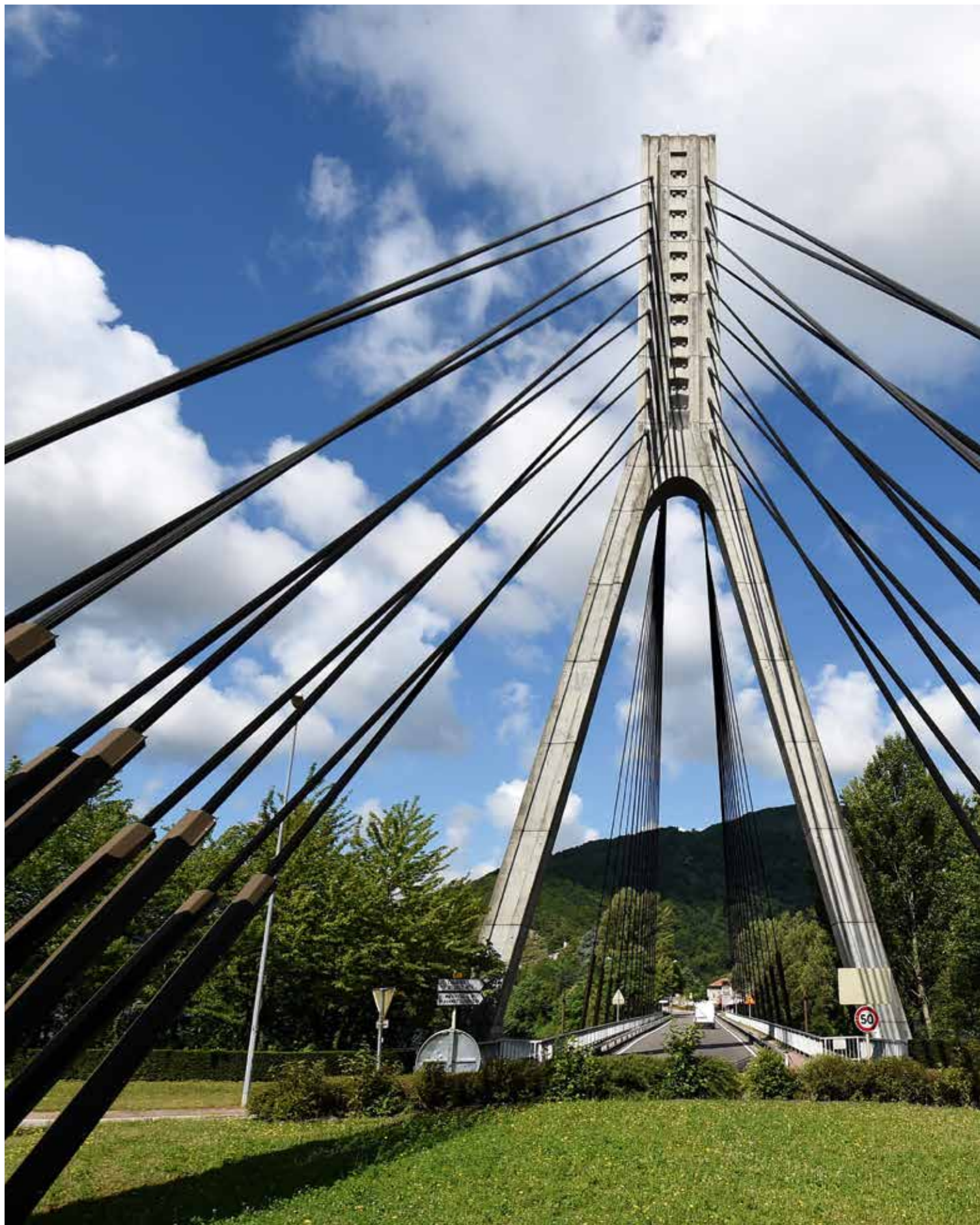
Pont du Pertuiset. L'entretien du réseau routier concerne aussi les ouvrages d'art. À Unieux, ce pont à câbles enjambe la Loire grâce à un seul pylône de 48 mètres de haut. Inauguré en 1989, il sera rénové à partir de cet été. Au programme : changement de tous les haubans et travaux de renforcement.
