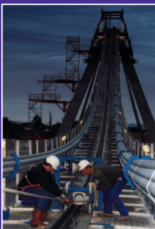
Pose des câbles de nuit.
