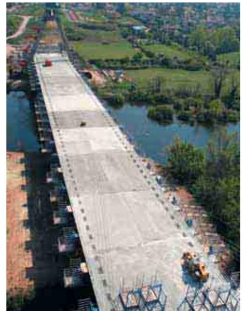
Avril 2007 : construction du tablier en béton (partie roulable du pont)
