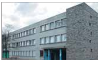
2 COLLÈGE LOUIS GRUNER À ROCHE-LA-MOLIÈRE
