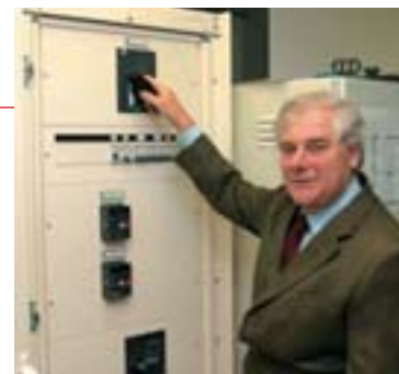
Pascal Clément met sous tension la tête de réseau très haut-débit de Saint-Étienne.
